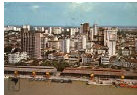
Estação das Docas - num passado recente Belém, PA
